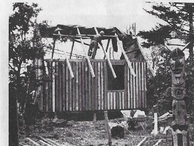
Patruljehytte under opførelse.
